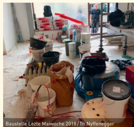
Baustelle Letzte Maiwoche 2018 / Th.Nyffenegger
